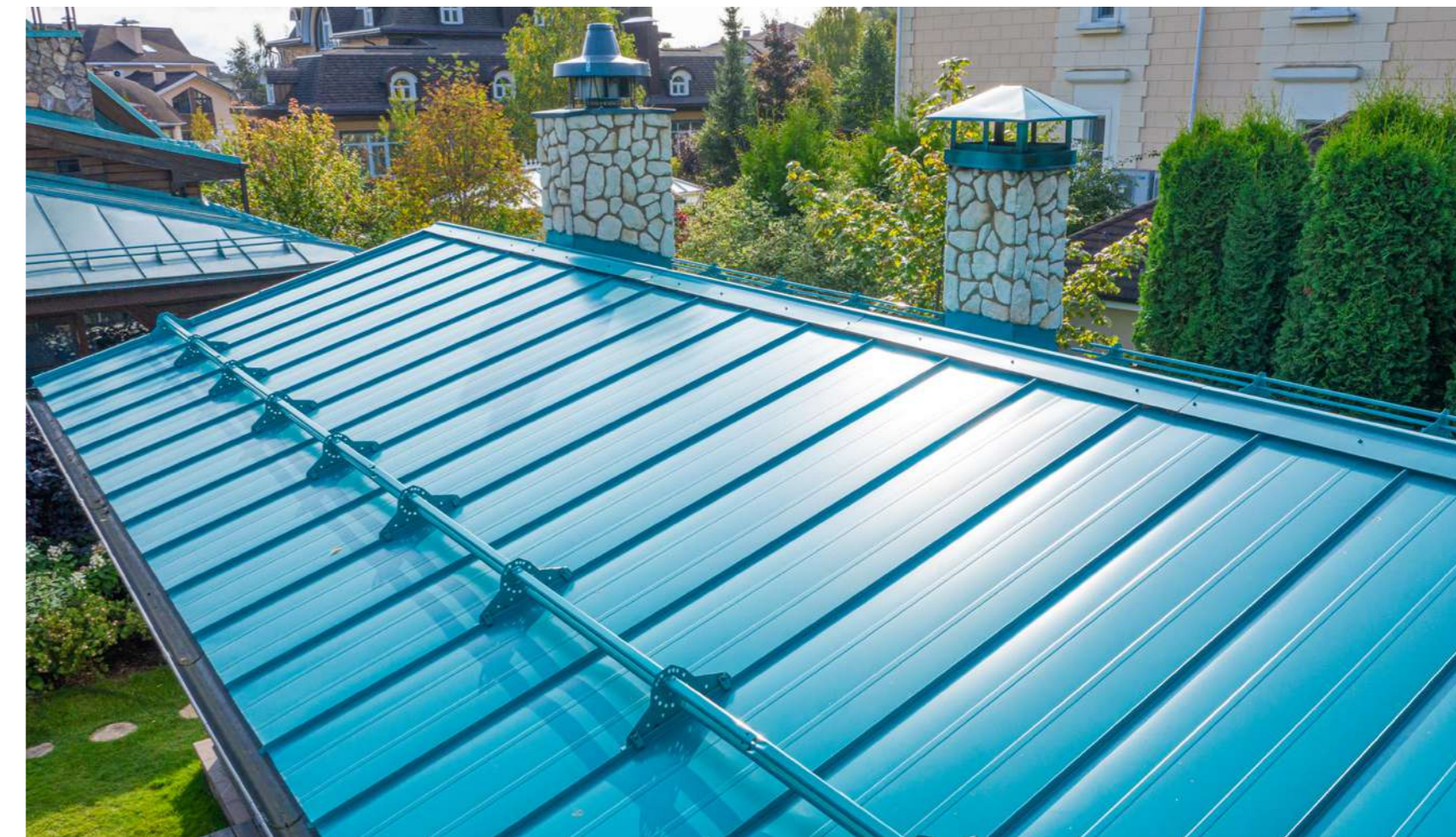
Кликфальц® Pro GreenCoat Pural BT Matt RR23 (RAL 7024), снегозадержатели для фальцевой кровли Grand Line, водосток металлический Grand Line 125/90 мм.
