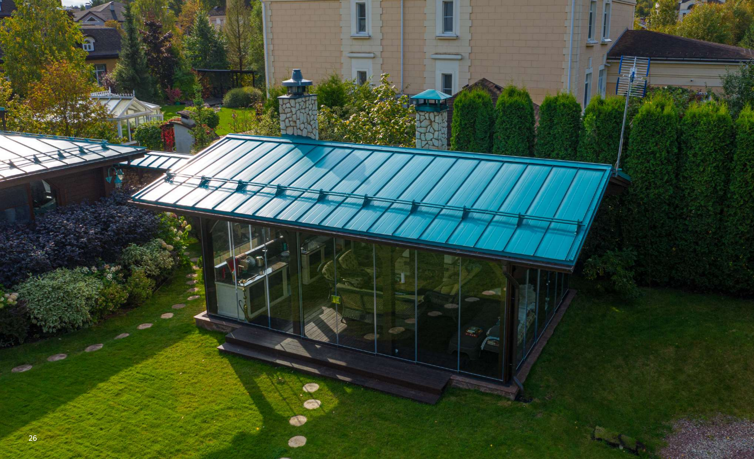
Кликфальц® Pro GreenCoat Pural BT Matt RR23 (RAL 7024), снегозадержатели для фальцевой кровли Grand Line, водосток металлический Grand Line 125/90 мм.
