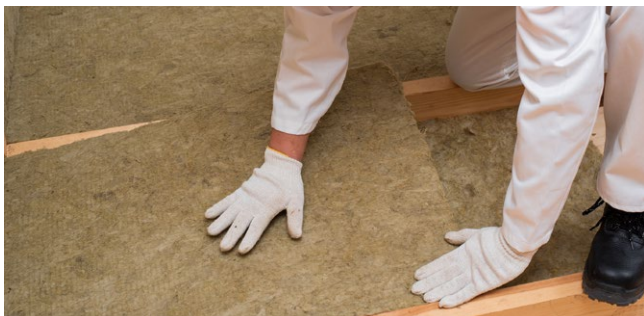
Рис. 1.11. Монтаж теплоизоляции между балками
