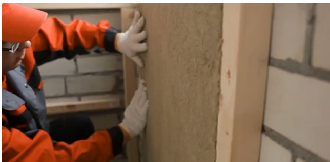
Рис. 3.2. Укладка плит теплоизоляции первого слоя
