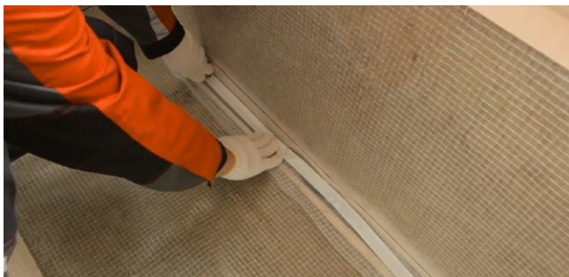
Рис. 3.11. Проклейка нахлестов пароизоляции
