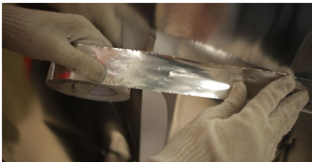
Рис. 2.3. Проклейка стыков пароизоляции
