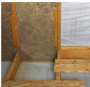
Рис. 1.2. Подготовленная система для дальнейшего монтажа теплоизоляции
