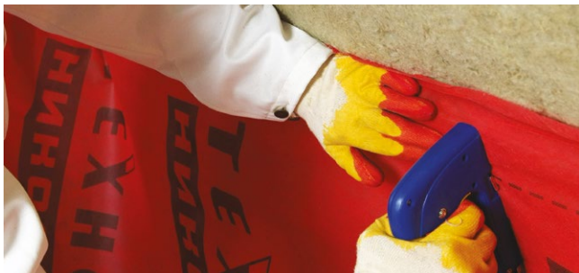
Рис. 1.5. Укладка и фиксация пароизоляционной пленки
