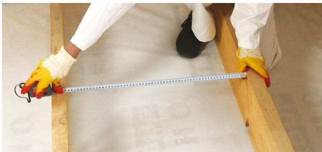
Рис. 1.9. Смонтированная пароизоляционная пленка
