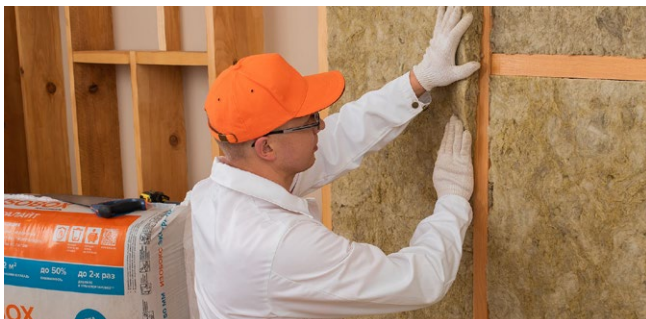
Рис. 1.3.б. Монтаж теплоизоляции враспор между стропилами
