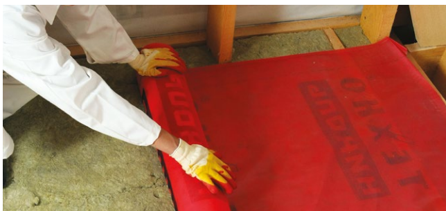
Рис. 1.12. Монтаж ветро-, влагозащитной мембраны
