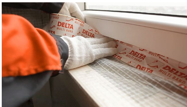
Рис. 3.12. Проклейка примыканий пароизоляции к стенам и окну
