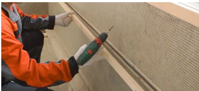
Рис. 3.6. Монтаж контррейки
