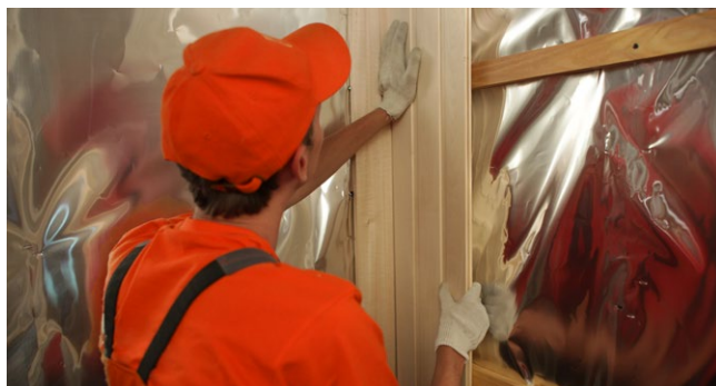
Рис. 2.4. Устройство внутренней обшивки
