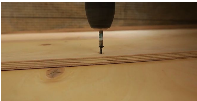
Рис. 3.13. Установка покрытия пола
