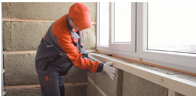
Рис. 3.4. Укладка плит теплоизоляции второго слоя
