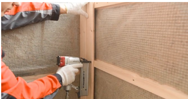
Рис. 3.7. Устройство внутренней обшивки
