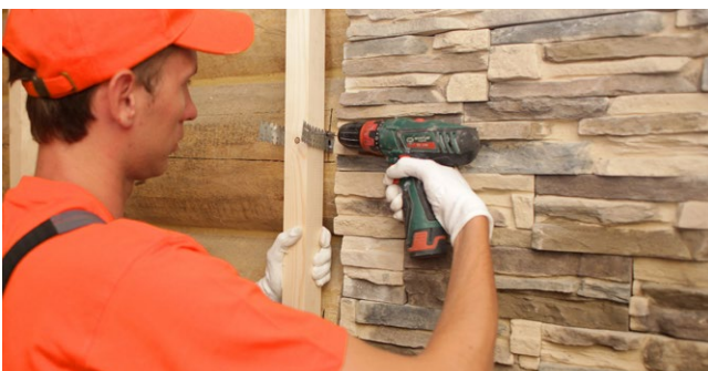
Рис. 2.1. Установка каркаса под теплоизоляцию
