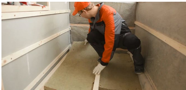
Рис. 3.9. Укладка теплоизоляционных плит
