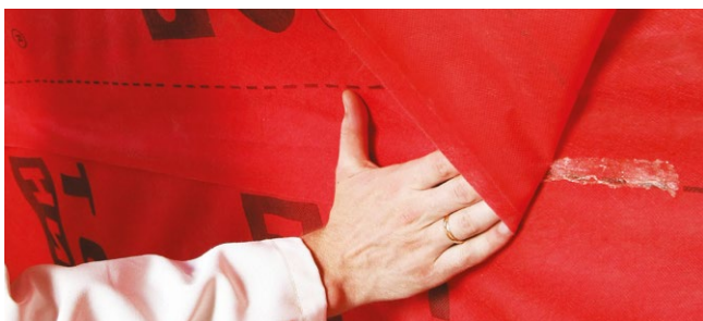
Рис. 1.6. Проклейка стыков пароизоляционной пленки
