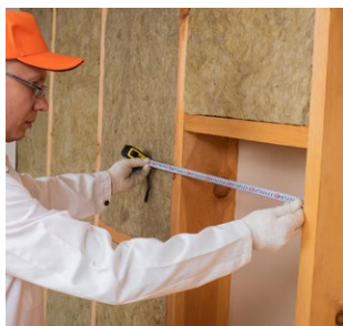
Рис. 1.2. Подготовленная система для дальнейшего монтажа теплоизоляции
