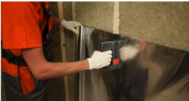
Рис. 2.3. Монтаж пароизоляции
