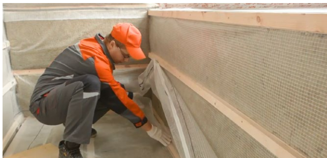
Рис. 3.10. Монтаж пароизоляционной пленки
