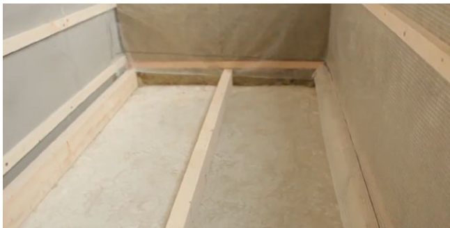
Рис. 3.8. Монтаж деревянных лаг на пол
