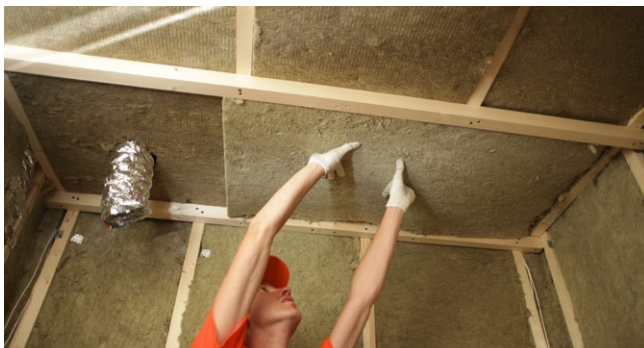
Рис. 2.2. Укладка плит теплоизоляции
