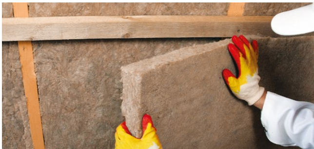
Рис. 1.4.6. Укладка второго слоя теплоизоляции
