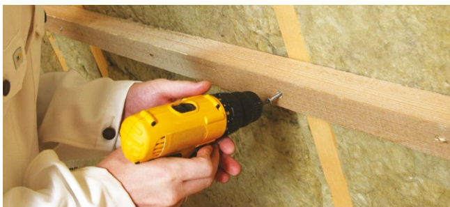
Рис. 1.4.а. Укладка второго слоя теплоизоляции
