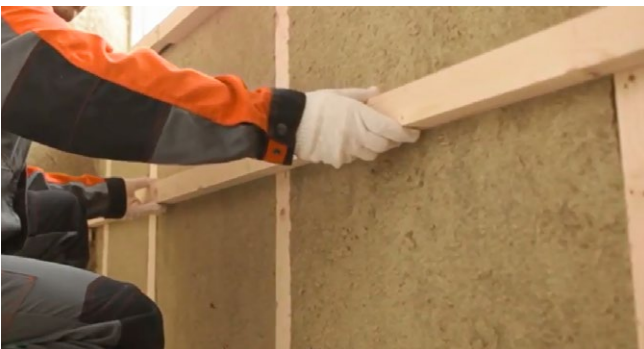
Рис. 3.3. Установка горизонтального каркаса под теплоизоляцию
