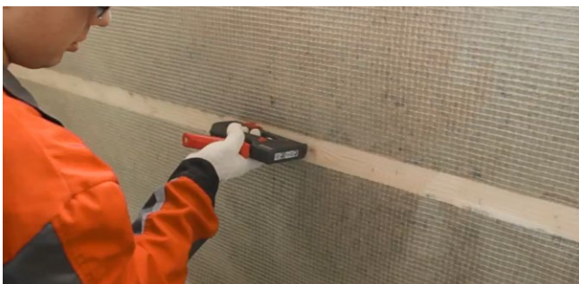
Рис.3.5. Монтаж пароизоляции
